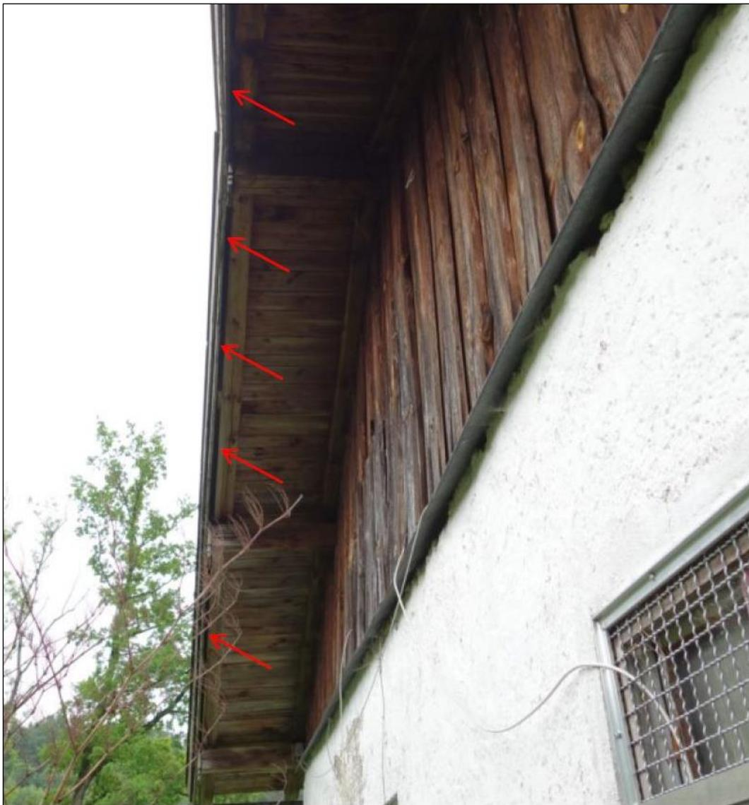
**Abb. 4** Spalt hinter Windbrett am kleinen Nebengebäude
