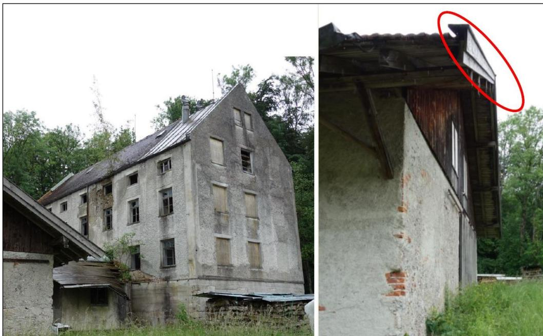
**Abb. 3** Hauptgebäude (1a, links) und Windbrett am Nebengebäude (1b, rechts)
